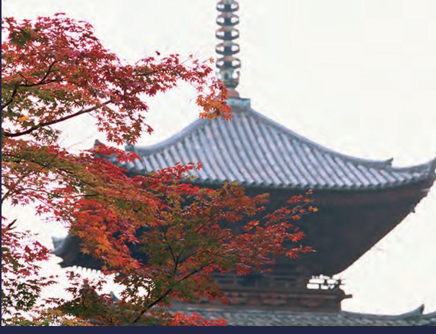
重要文化財 三重塔
